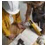
Строительство и отделка
